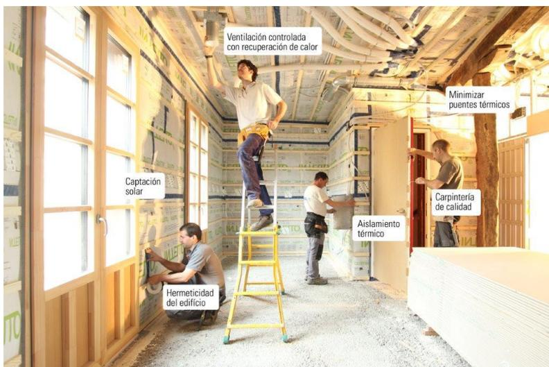
Foto: Componentes del estándar Passivhaus – Fuente: Bau Passivhaus sl
