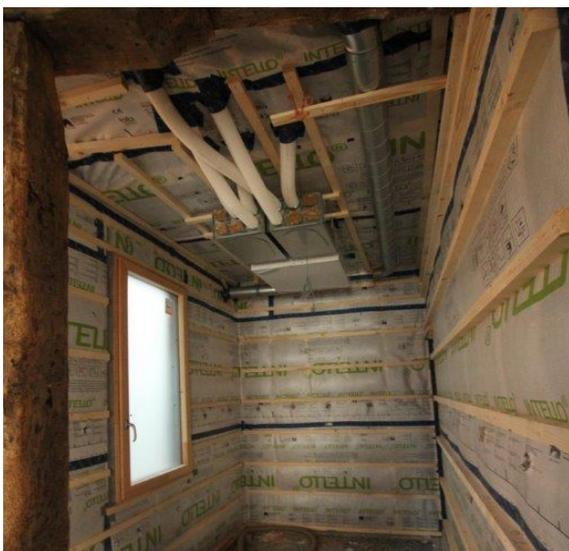
Foto: Instalación de ventilación–Fuente: Bau Passivhaus
