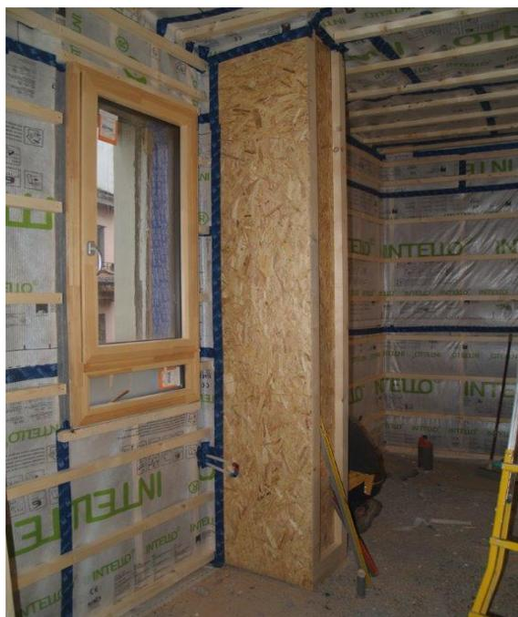
Foto: Cajón de la caldera – Fuente: Bau Passivhaus
