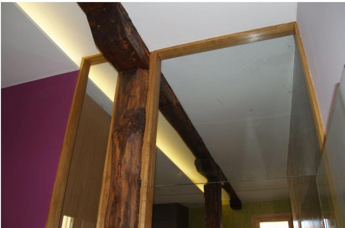
Foto: Estructura principal de madera a la vista – Fuente: Bau Passivhaus sl
